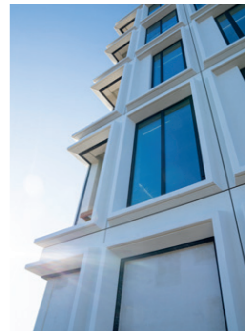
Strakke hoekdetailering van het kantoorgebouw - Fotostudio Eye 4 You
