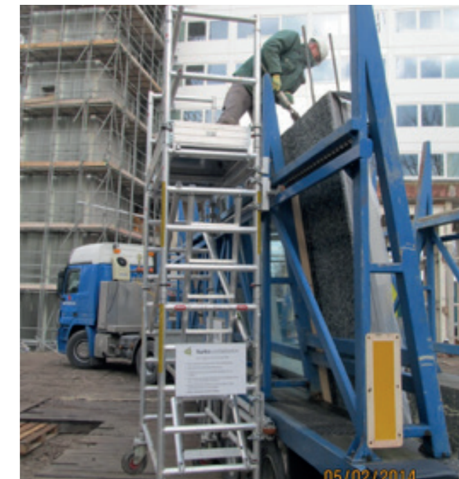
De hangrol steiger om zonder een ladder eenvoudig en veilig kuipwagens te kunnen lossen.
