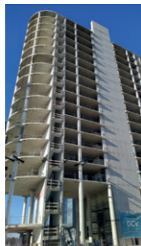
De gesloopte gevel van de bestaande kantoortoren wordt rondom uitgebreid en opnieuw bekleed met aluminium vliesgevel (kantoortoren).
