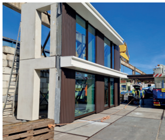
Mock-up van twee verdiepingen compleet gemonteerd op ons fabrieksterrein ter beoordeling door opdrachtgever (woontoren).
