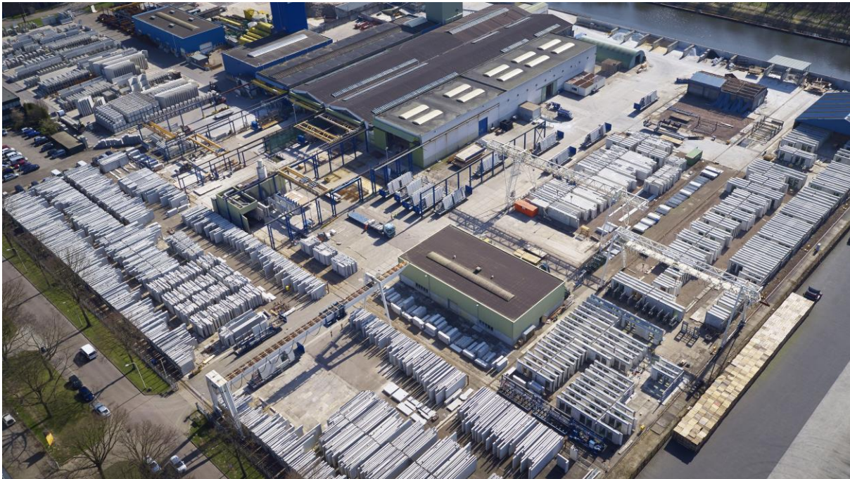
Foto Byldis Prefab locatie Tilburg
