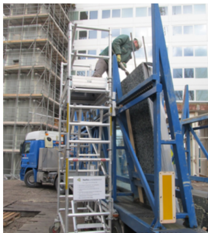
De hangrol steiger om zonder een ladder makkelijker en veiliger kuipwagens te kunnen lossen.
