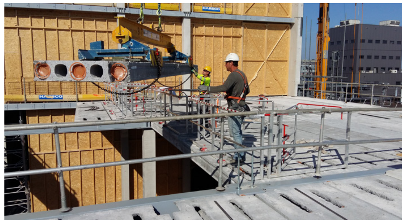
De eerste toepassing van het, in eigen beheer ontwikkelde, belt-free systeem voor het veilig monteren van kanaalplaatvloeren.
