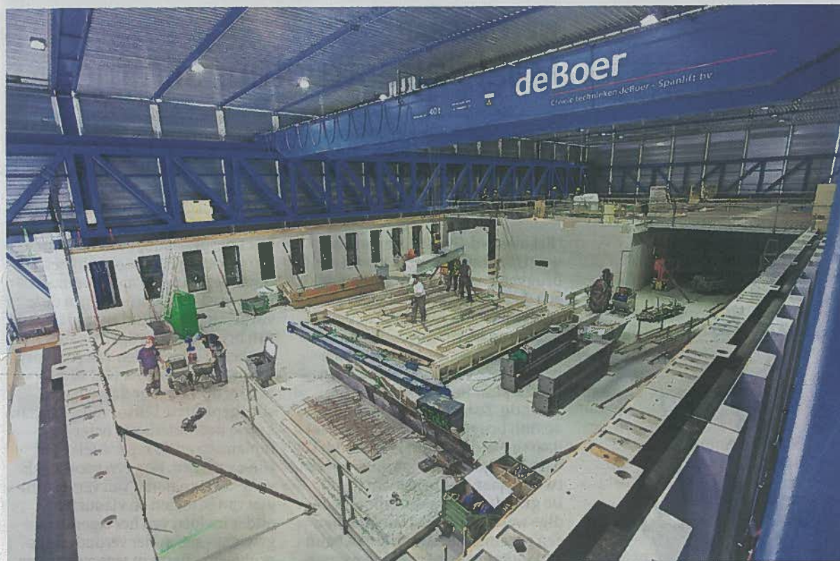
Met een tweede 40-tons bovenloopkraan worden de materialen op bestemming afgeleverd in de hal.
