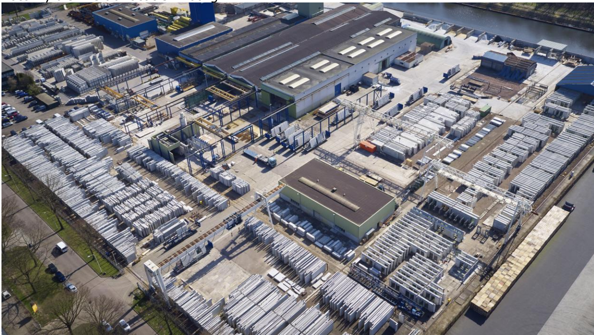
Foto Byldis Prefab locatie Tilburg
