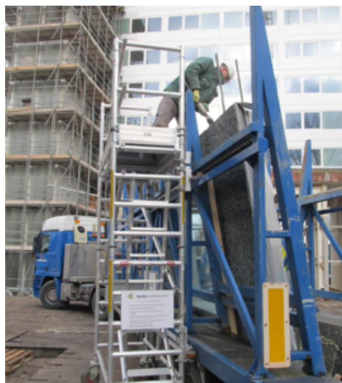
De hangrol steiger om zonder een ladder eenvoudig en veilig kuipwagens te kunnen lossen.
